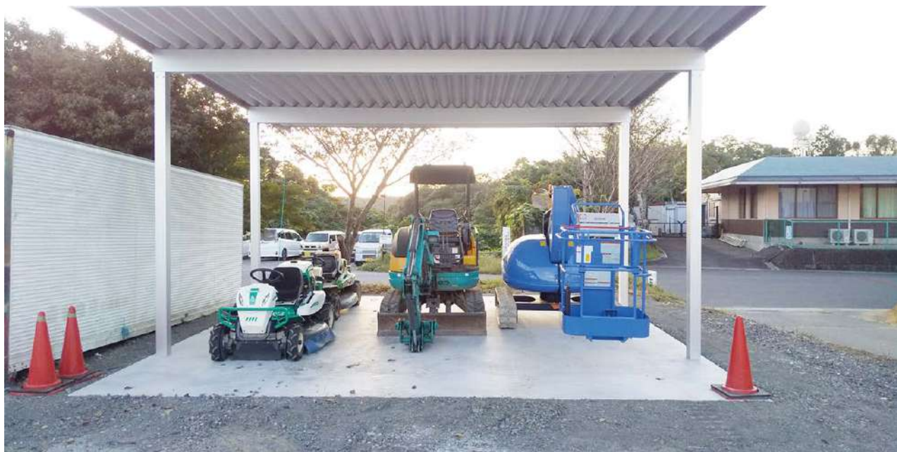
完成した重機置き場
